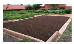
Dans notre zone production du Sud du Maroc (Dakhla), 10 stations d'épurations ont été implantées afin de traiter les effluents de nos fermes, via un traitement adapté au milieu rural composé de diverses couches de sables et graviers, composant ainsi un filtre à sol.
